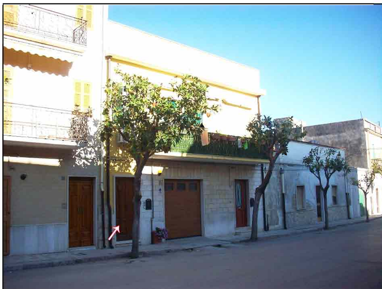
FOTO 2: Accesso all'immobile esecutato da via Foggia, 26
