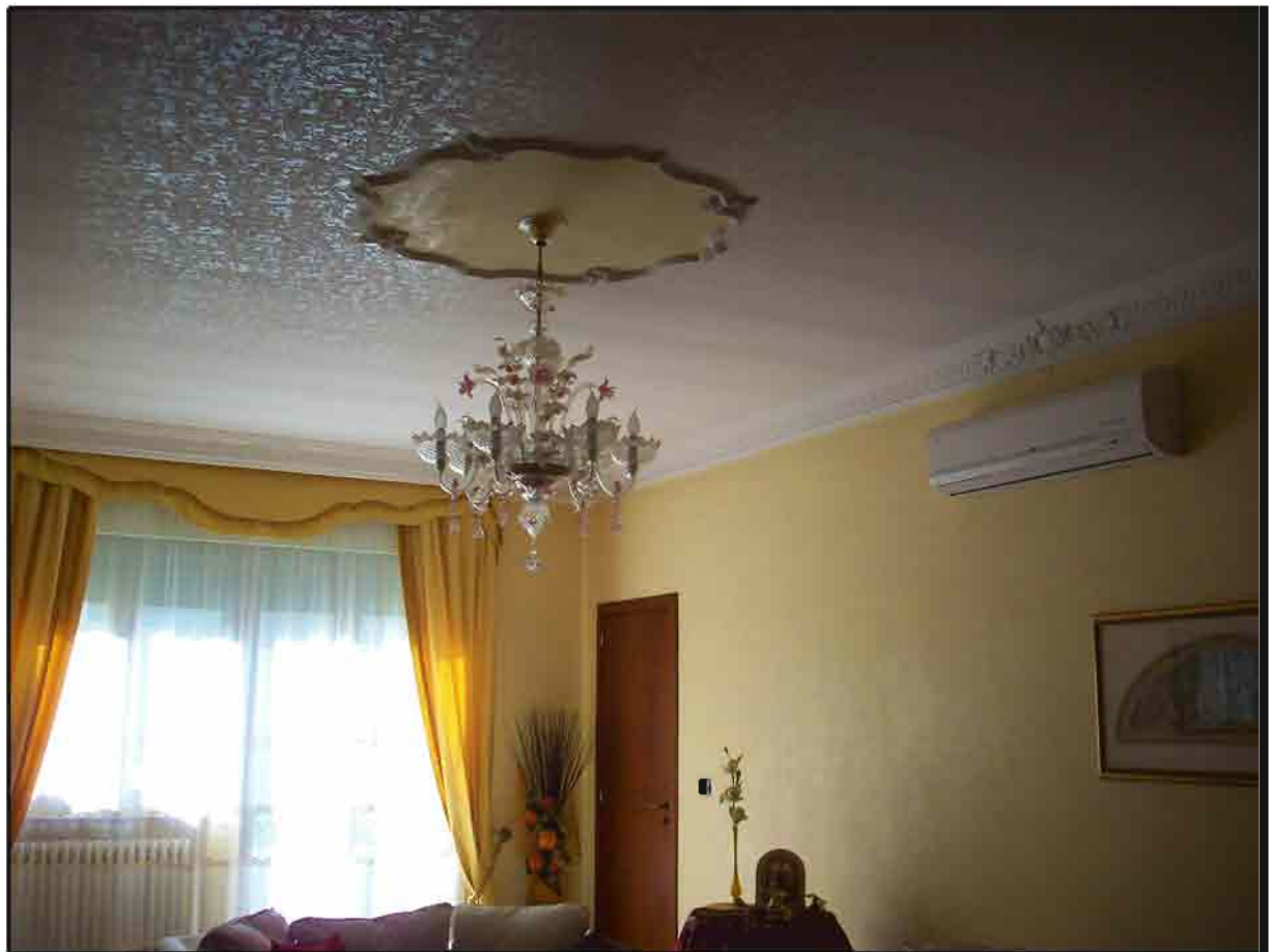
FOTO 5: Soggiorno dell'appartamento: dettagli delle lavorazioni in gesso sul soffitto e sulle cornici.
